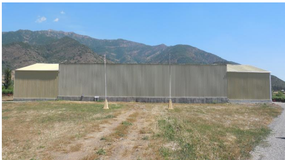
Ilustración 5: Vista norte de bodega de vinificación.
